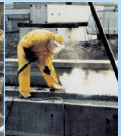
Freilegen von Bewehrungsstählen
