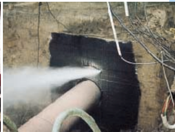
Schneiden von Stahlbeton
