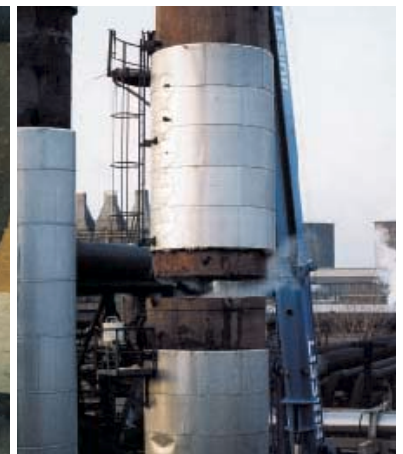
Zerlegen von Stahlkonstruktionen
