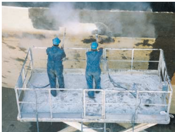
Untergrundvorbereitung im Zwei-Pistolen-Betrieb
